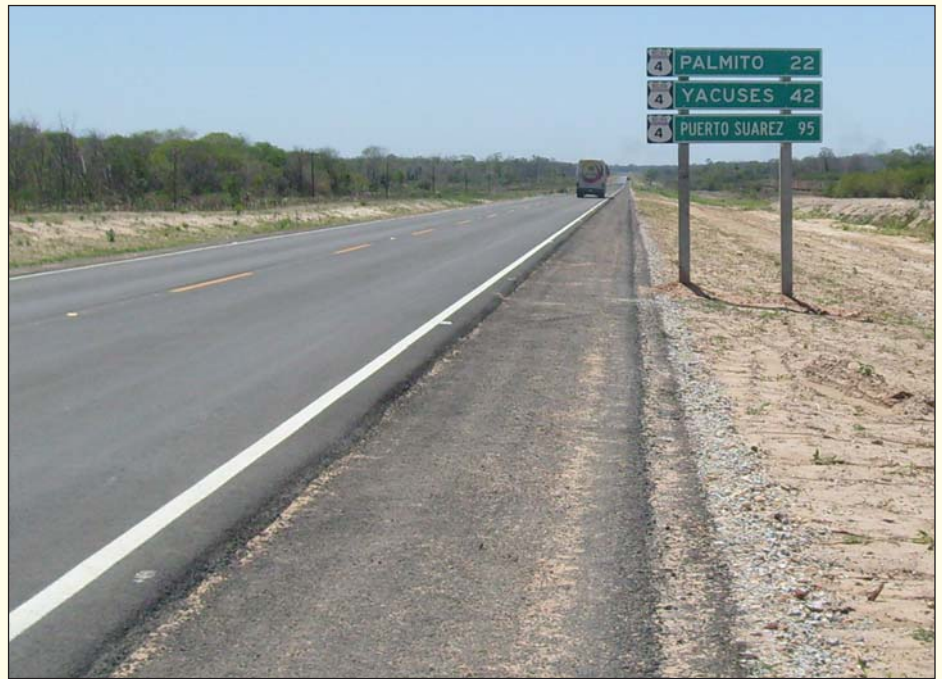
Pavimento flexible en el tramo concluido El Carmen - Arroyo Concepción - Puerto Suarez (102 km).
