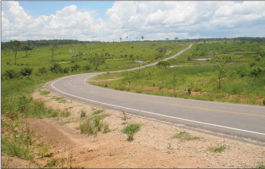
Tramo Roboré - El Carmen ya concluido para el tránsito normal de vehículos
