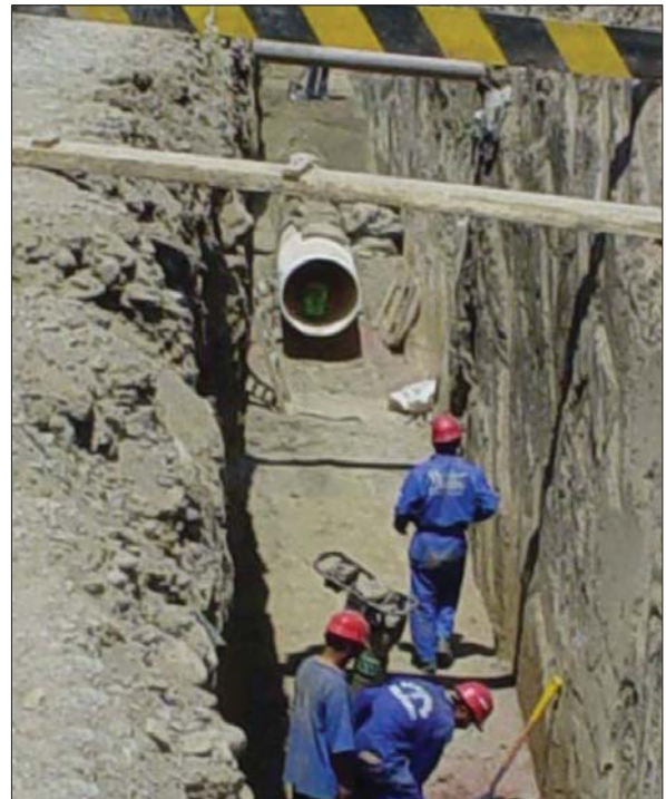
Instalación de tubos helicoidales en sistema de drenaje pluvial .
