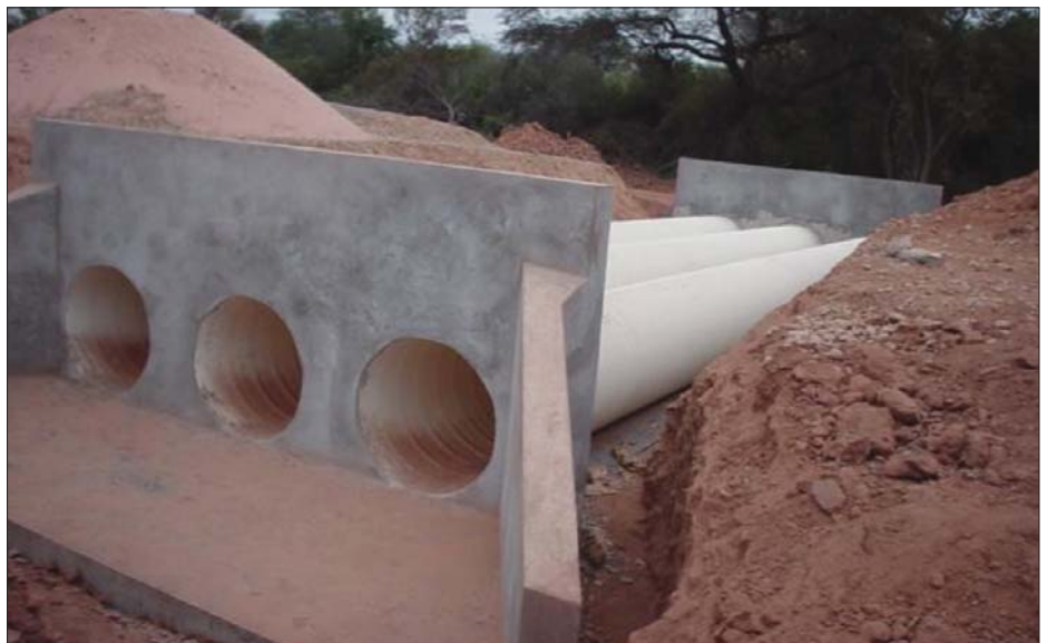
Alcantarilla de tres tubos, TUBOFLEX (Villamontes - La Vertiente).
