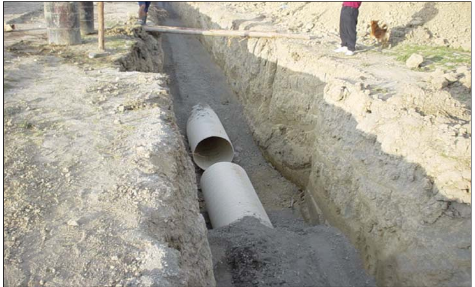
Instalación de tubos helicoidales en sistema de drenaje pluvial.
