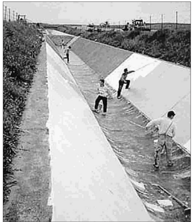
Aplicando pintura reflectiva sobre manta asfáltica en un canal de transporte de agua.
