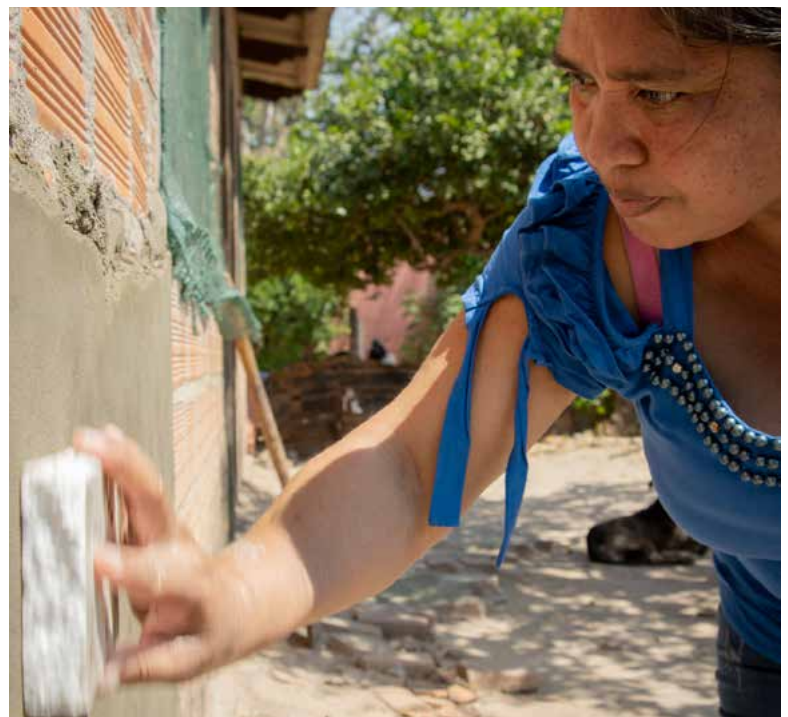
Beneficiaria participando activamente en las obras.
