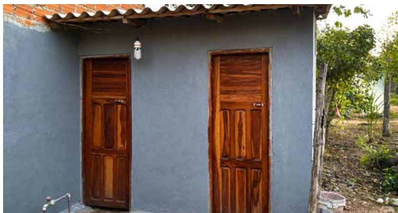
Acabado superficial de baños de un beneficiario.
